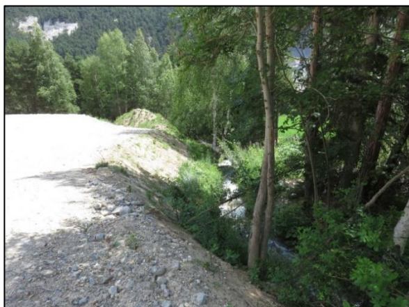
Photo 7 : Le remblaiement de la voie d'accès en limite rive gauche du ruisseau
